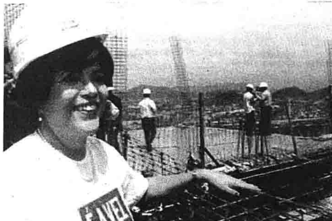
A presidente Dilma em visita a um dos canteiros do Governo Federal no Nordeste, onde estão grandes obras do PAC
