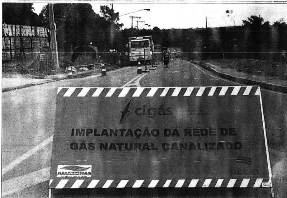
Atualmente, três frentes de obra, conduzidas pela PCCM, estão a 'todo vapor' para levar o gás às indústrias e ao Posto Equador
