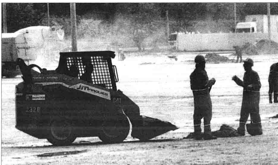
Embora tenha grande quantidade de demandas em todo o Estado, o governo informou que pretende dar prioridade às obras
