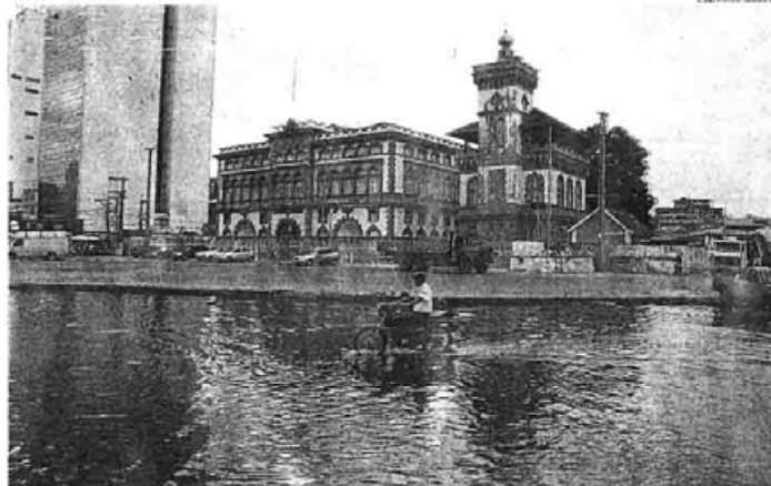
Justiça Federal mandou embargar atividades no prédio da Receita (à esquerda) por contaminação após a cheia
