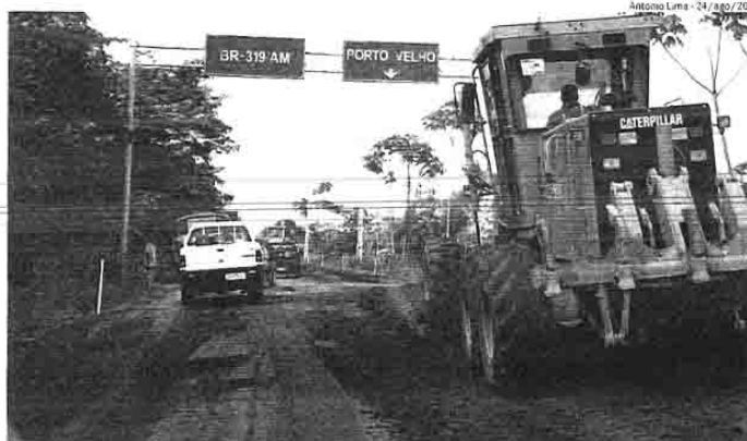
Durante expedição realizada em agosto deste ano, representantes do Dnit viram de perto os problemas que a obra enfrenta
