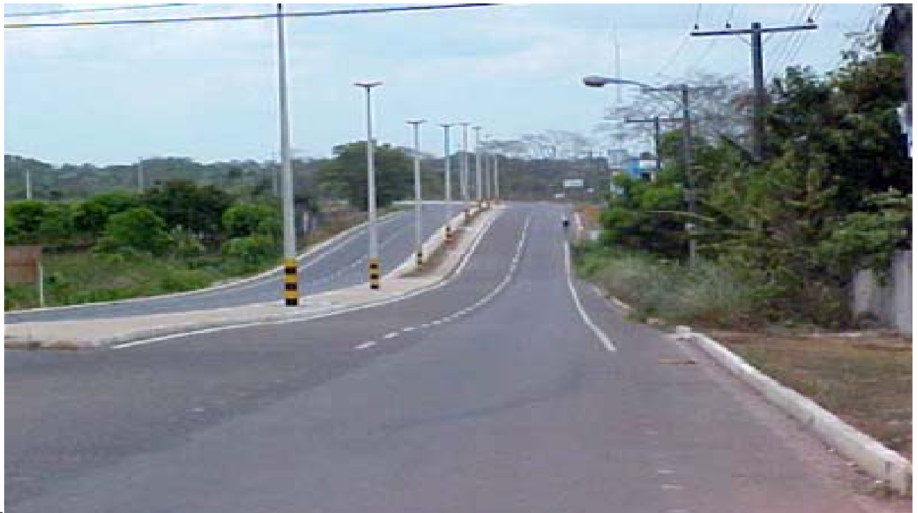
Infra-estrutura Economica: recuperação de estradas
