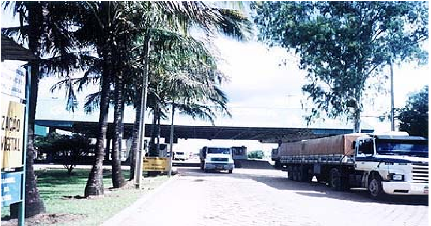
“Portal da Amazônia” - Vista externa do pátio de manobra de cargas
