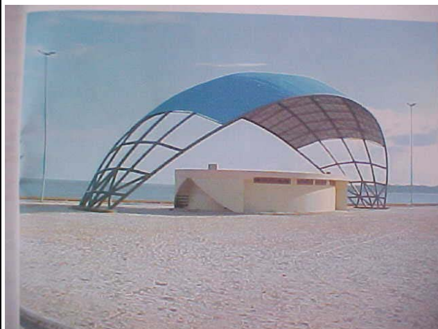
Palco com estrutura metálica
