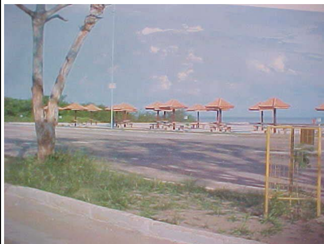
Pintura, elemento vazado e portão frontal
