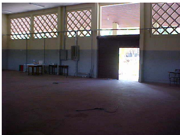
Pintura, elemento vazado e portão frontal
