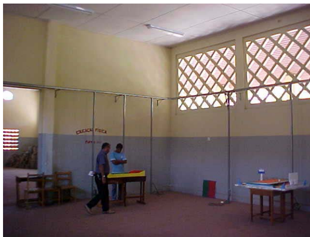
Instalações e pintura
