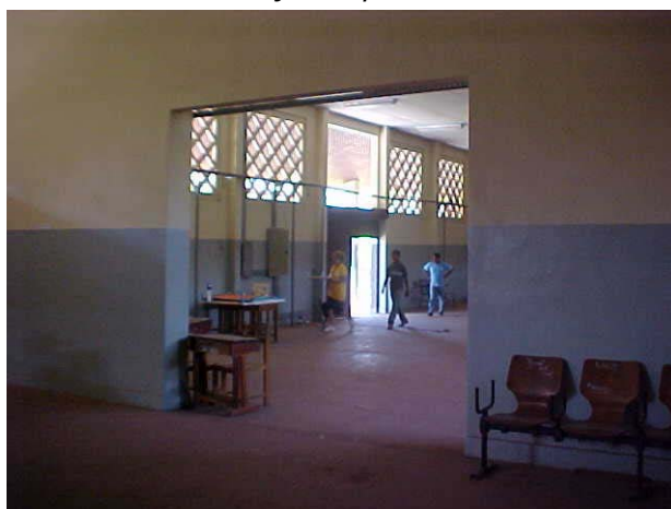
Vista do interior da escola
