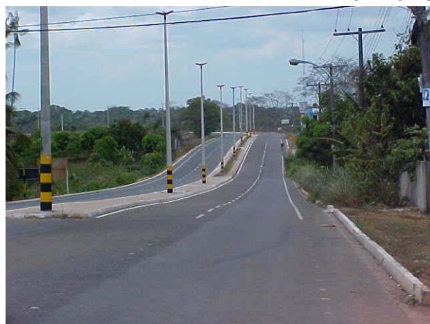
Sinalização das sarjetas com linha
