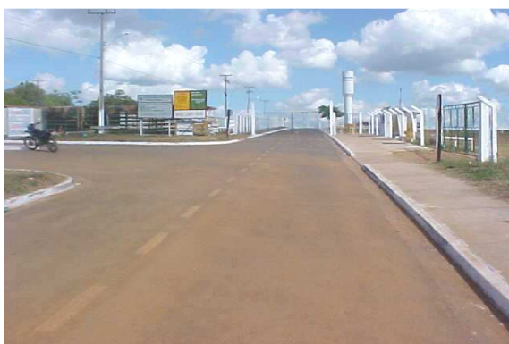
Pavimentação Asfáltica do Parque de Exposição
