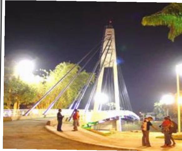
• Ponte binacional Brasil/Bolívia
