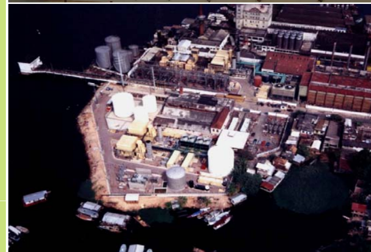
COMPLEXO TERMELÉTRICO DE APARECIDA – 251 MW
