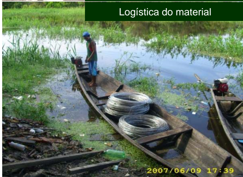
Arraste manual de poste
