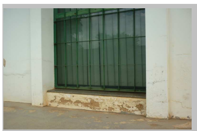
• PAREDE EXTEIOR - RIO BRANCO
