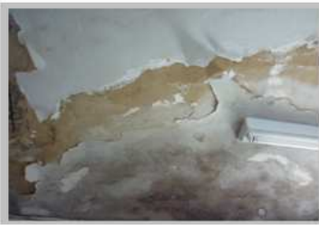
• TETO DO BANHEIRO • RIO BRANCO
