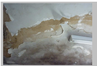
• TETO DO BANHEIRO • RIO BRANCO
