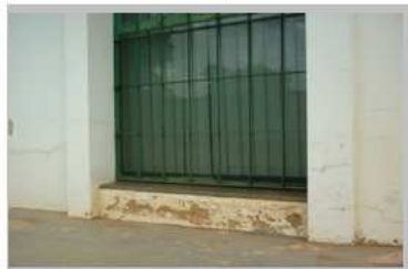
• PAREDE EXTEIOR - RIO BRANCO Feijó
