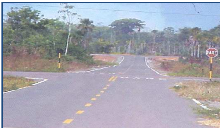
Pavimentação do Distrito Industrial de Santana
