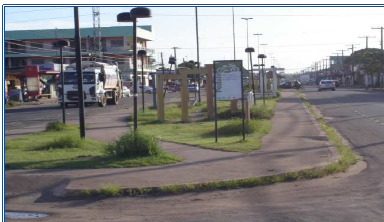
Urbanização da Avenida Claudomiro de Moraes Drenagem, terraplanagem e pavimentação asfáltica
