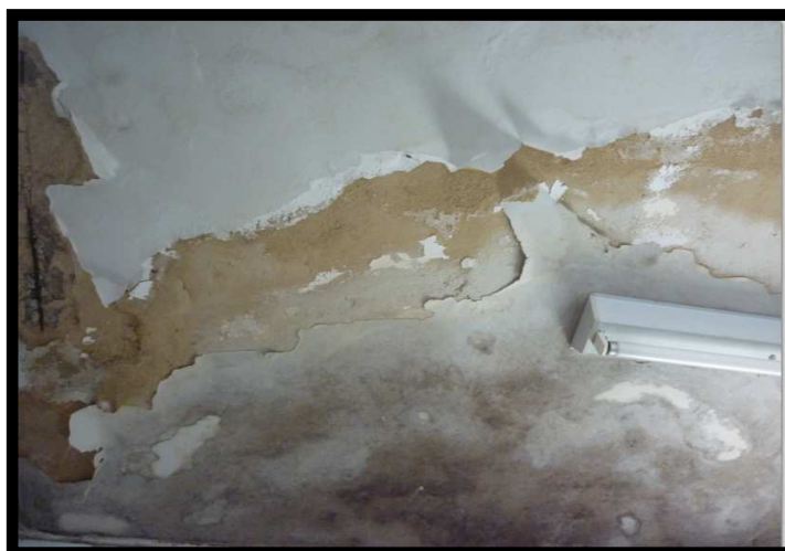
Vista do interior do teto da Sede Rio Branco - banheiro
