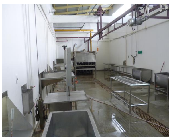
Figura 47 – Sala interna de matadouro de suínos
