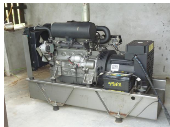
Figura 17 – Gerador de eletricidade
