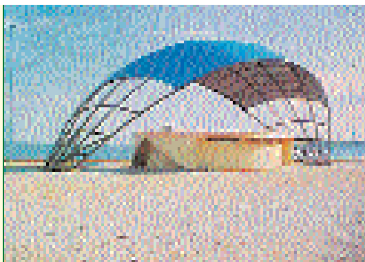
1 - Palco com estrutura metálica
