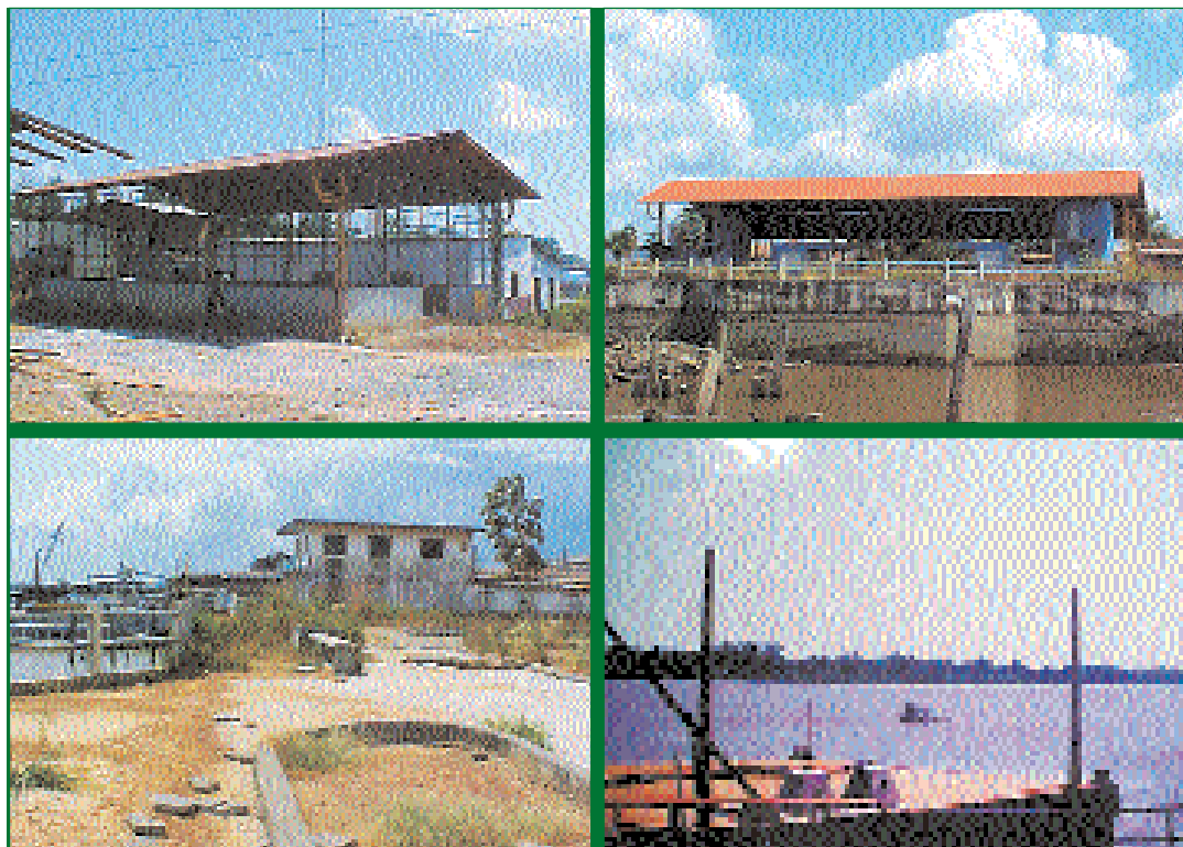
Trechos da execução do Terminal de Santana
