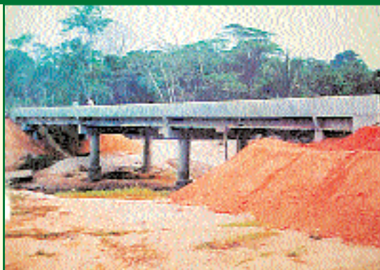
3 - Ponte sobre o Rio Riachuelo RO-480
