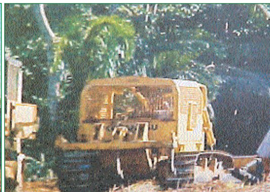
2 - Equipamentos na abertura de vicinais
