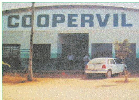
1 - Vista da fachada principal
