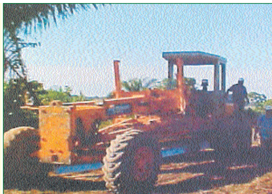
1 - Um dos equipamentos trabalhando na abertura da Vicinal Jericó, com 30 famílias beneficiadas
