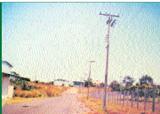
2 - Rede Elétrica de alta e baixa tensão/Pavimentação
