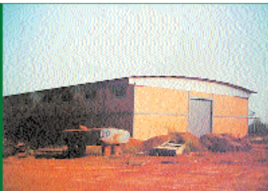
2 - Vista do Armazém
