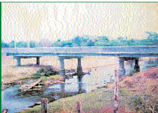
2 - Ponte sobre o Rio Paraíso RO-470
