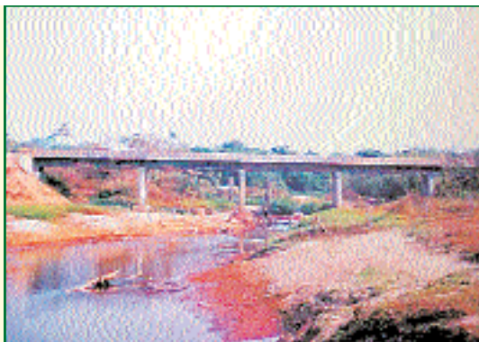
1 - Ponte sobre o Rio Branco em Ariquemes
