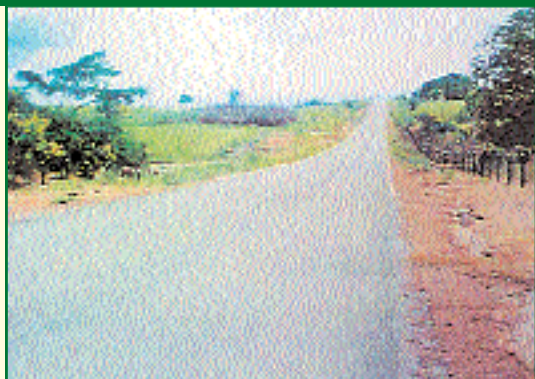
3 - Vista da Pavimentação Asfáltica da RO-010
