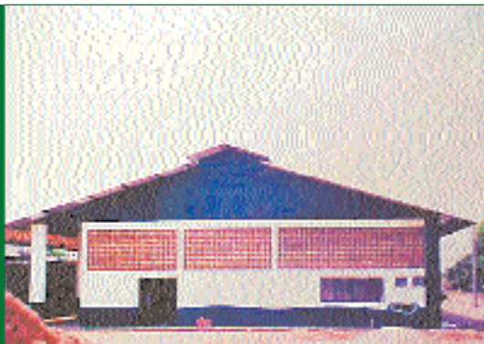
2 - Vista Geral do Galpão Metálico
