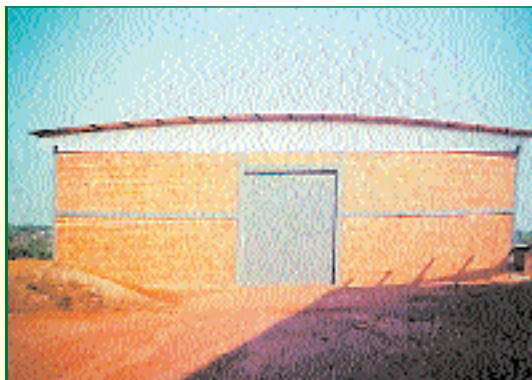
1 - Vista do Armazém
