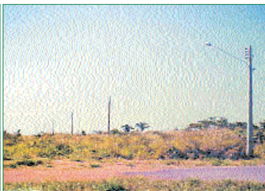
1 - Um dos trechos beneficiado com a rede de eletrificação
