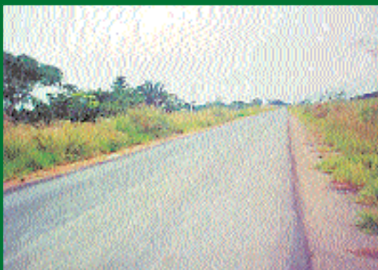
4 - Vista da Pavimentação Asfáltica da RO-135
