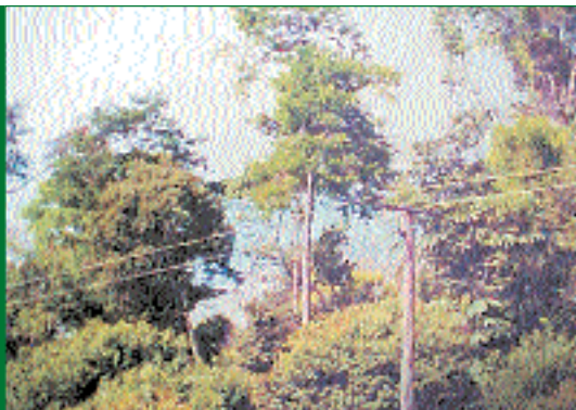
2 - Eletrificação da Linha CP 96
