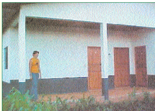
1 - Fachada do prédio
