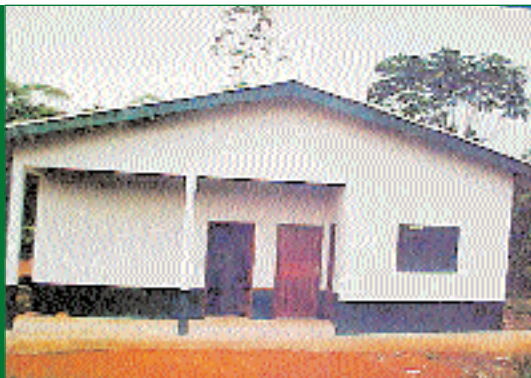
2 - Vista do Prédio Indústria Caseira
