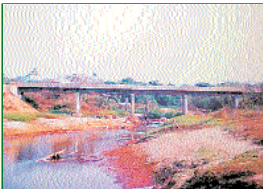
1 - Ponte sobre o Rio Branco em Ariquemes
