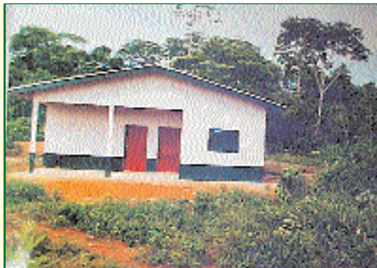
1 - Vista do Prédio Indústria Caseira
