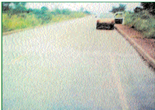
1 - Vista da Pavimentação Asfáltica da RO-010
