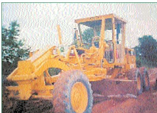
1 - Vista dos equipamentos em recuperação de vicinais
