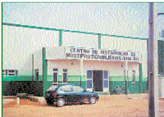
1 - Vista do Prédio
