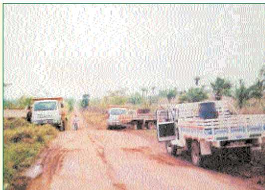
1 - Vista dos equipamentos adquiridos e da estrada sendo recuperada.
