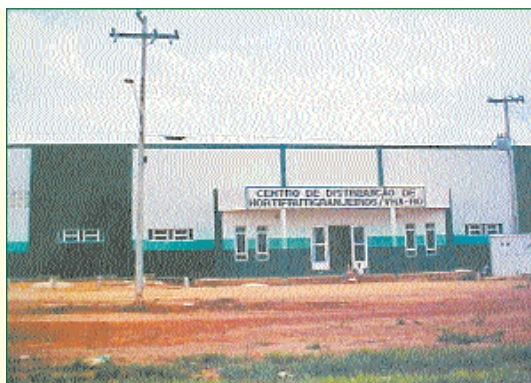
1 - Vista da fachada principal do Centro
