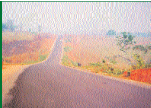
2 - Vista da Pavimentação da RO-010
