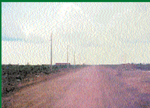
4 - Vista da R. São Paulo com revestimento primário
