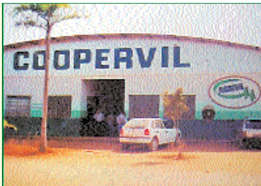
1 - Vista Geral do Prédio
