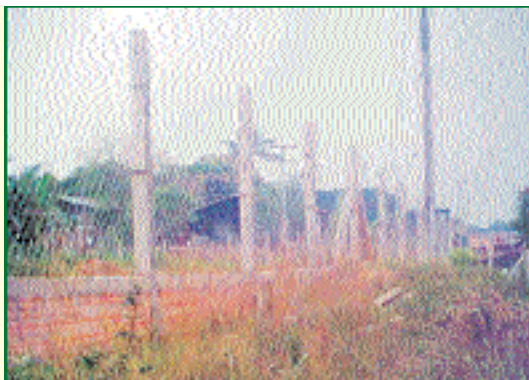
1 - Detalhe da Cerca de proteção
