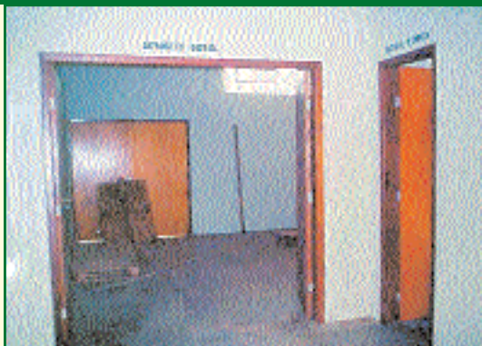
3 - Vista Interna do Prédio
