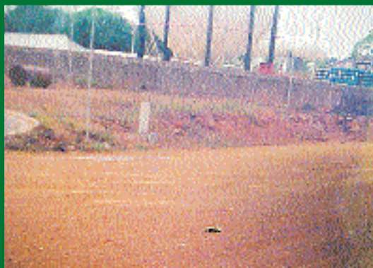
4 - Detalhe Aterro Totalizado da área de Acostagem
