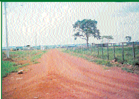
3 - Vista da R. São Paulo com revestimento primário
