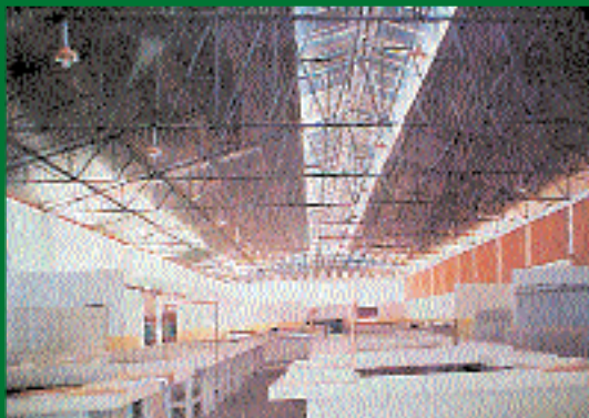
4 - Vista Interna do Galpão Metálico
