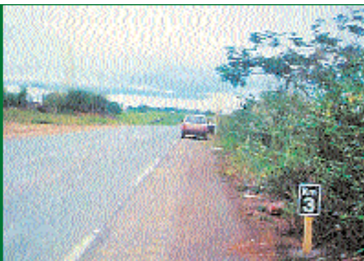
2 - Vista da Pavimentação Asfáltica da RO-135
