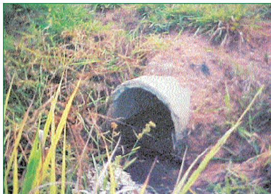
2 - bueiro com Ø de 60 cm localizado na linha 98 a 500m do travessão N na zona Rural
