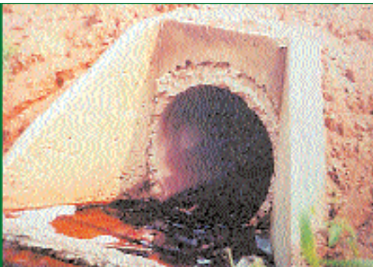
2 - Vista da Vicinal 180 - bueiro recuperado
