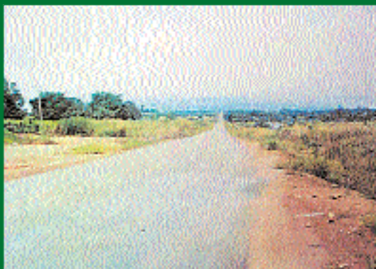
4 - Vista da Pavimentação Asfáltica da RO-010
