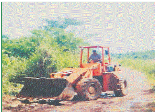
2 - Pá carregadeira executando trabalho de manutenção de vicinais
