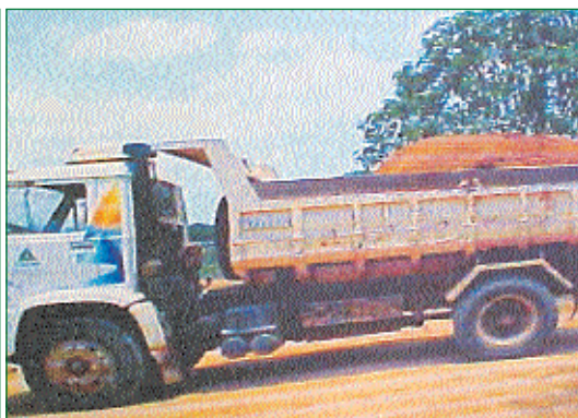
2 - Transporte de aterro
