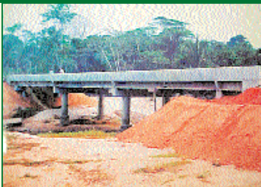
3 - Ponte sobre o Rio Riachuelo RO-480
