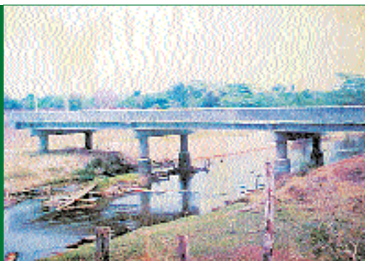
2 - Ponte sobre o Rio Paraíso RO-470
