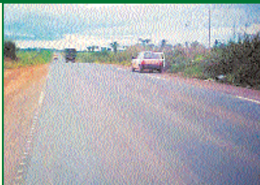
3 - Vista da Pavimentação Asfáltica da RO-135
