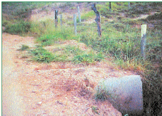
1 - bueiro com Ø de 60 cm localizado na linha 98 a 4300m do travessão N na zona Rural
