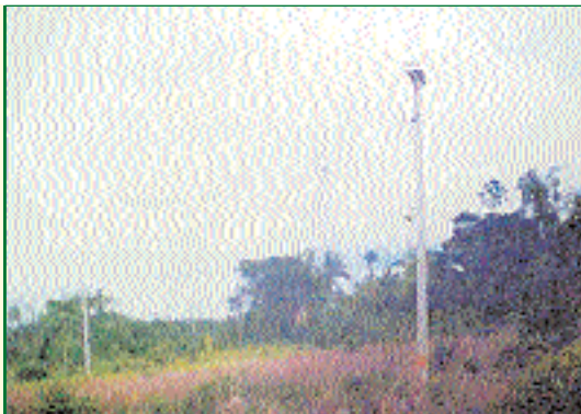
1 - Rede Elétrica Linha 659
