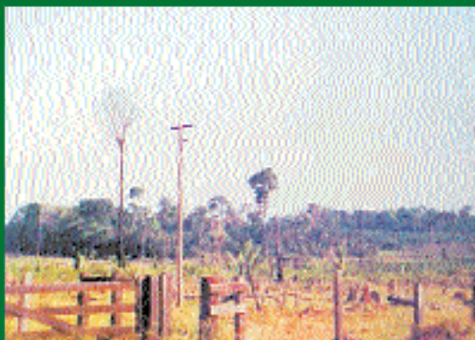
4 - Vista da Rede Elétrica de Alto Paraíso
