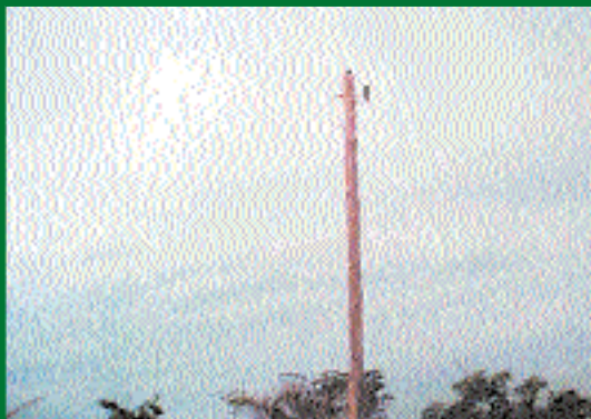
4 - Eletrificação da Linha CC 02
