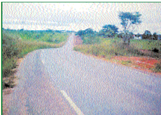
1 - Vista da Pavimentação Asfáltica da RO-135
